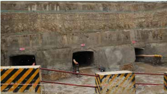
Ujenzi wa mahandaki matatu ya kupeleka maji ya kuzungusha mitambo ya kufua umeme kwa kutumia maporomoko ya maji ya Bonde la Mto Rufiji katika Mradi wa Umeme wa Julius Nyerere (JNHPP), ukiendelea wakati wa ziara ya Naibu Katibu Mkuu wa Wizara ya Nishati, Mhandisi Leonard Masanja kukagua maendeleo yake, Agosti 22, 2020.
