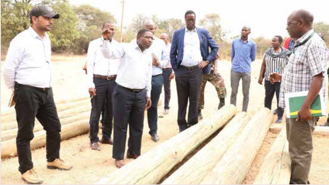
Waziri wa Nishati Dkt Medard Kalemuni (mwenye miwani-kushoto), akimwagiza Meneja wa TANESCO Mkoa wa Dodoma, Mhandisi Frank Chambua (kulia), kuhakikisha anamsimamia Mkandarasi anayetekeleza Mradi wa Umeme Vijijini Awamu ya Tatu Mzunguko wa Kwanza, mkoani Dodoma, Kampuni ya A2Z Infra Engineering Limited, kusimika nguzo zote zilizorundikwa chini na kuwaunganisha wananchi umeme. Waziri alikuwa katika ziara ya kazi, wilayani Chemba, Agosti 12, 2020.
