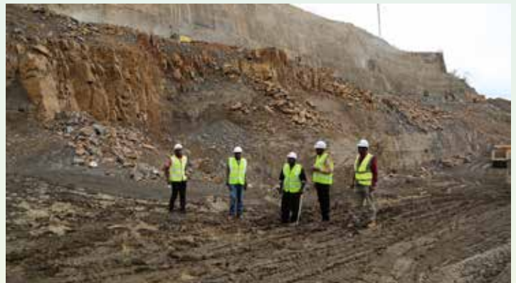
Naibu Katibu Mkuu wa Wizara ya Nishati, Mhandisi Leonard Masanja (katikati) akitazama shughuli za ujenzi zinazoendelea katika Mradi wa Umeme wa Julius Nyerere (JNHPP), alipofanya ziara ya kukagua maendeleo yake, Agosti 22, 2020. Kushoto kwake ni Mhandisi Mkazi na Mshauri wa Mradi huo, Mhandisi Mushubila Kamuhabwa.
