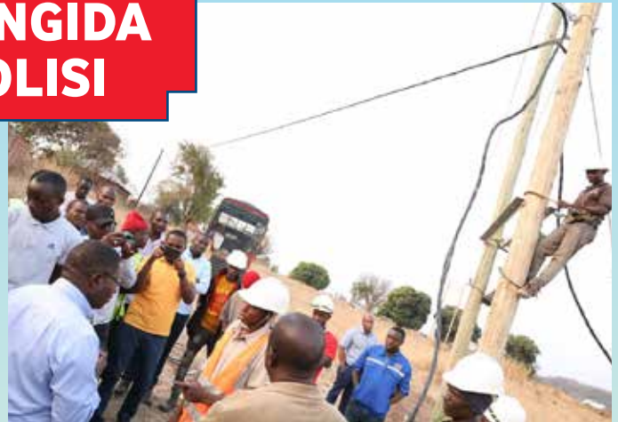
Waziri wa Nishati Dkt Medard Kalemani (kushoto), akizungumza na vibarua wa Mkandarasi anayetekeleza Mradi wa Umeme Vijijini Awamu ya Pili (REA II), mkoani Singida, alipotembelea kukagua kazi inayoendelea katika kijiji cha Kisiriri, wilayani Iramba, Agosti 13, 2020.
