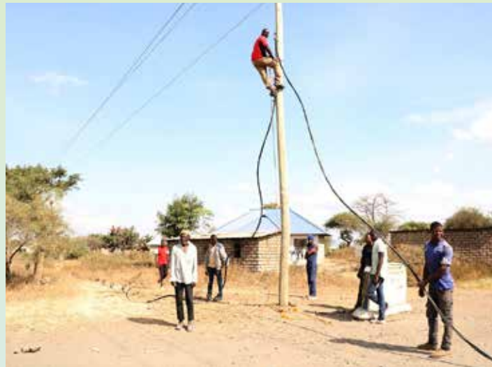
Baadhi ya Vibarua wa Mkandarasi anayetekeleza Mradi wa Umeme Vijijini wilayani Hai, Mkoa wa Kilimanjaro wakiendelea na kazi katika Kitongoji cha Kambi ya Nyuki, wakati wa ziara ya Waziri wa Nishati Dkt Medard Kalemani wilayani humo, Agosti 17, 2020.
