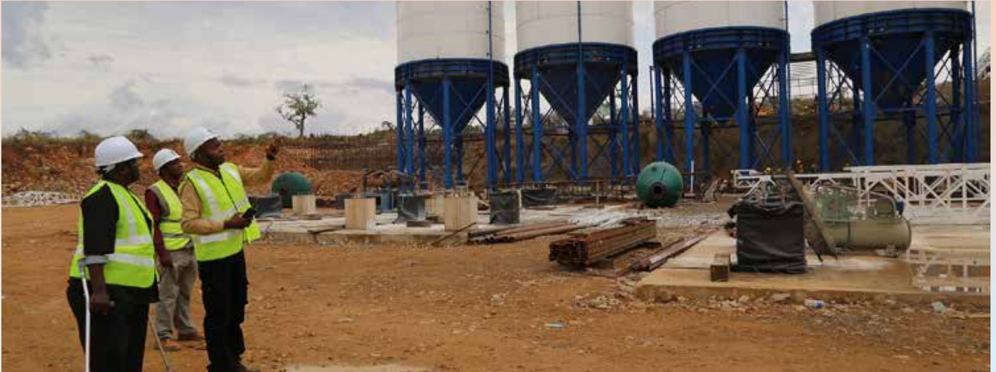
Naibu Katibu Mkuu wa Wizara ya Nishati, Mhandisi Leonard Masanja (kushoto) akipata maelezo ya ufanyaji kazi wa mitambo ya kuchanganya zege kutoka kwa Mhandisi Mkazi na Mshauri wa Mradi wa Umeme wa Julius Nyerere (JNHPP), Mhandisi Mushubila Kamuhabwa (kulia), wakati wa ziara yake kukagua maendeleo ya ujenzi wa Mradi husika, Agosti 22, 2020.
