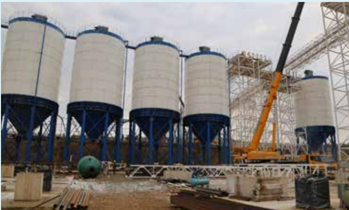
Mwonekano wa mitambo ya kuchanganya zege inayotumika wakati wa ujenzi wa bwawa la kufua umeme katika Mradi wa Umeme wa Julius Nyerere (JNHPP). Naibu Katibu Mkuu wa Wizara ya Nishati, Mhandisi Leonard Masanja alifanya ziara ya kukagua maendeleo ya ujenzi wa Mradi huo, Agosti 22, 2020.
